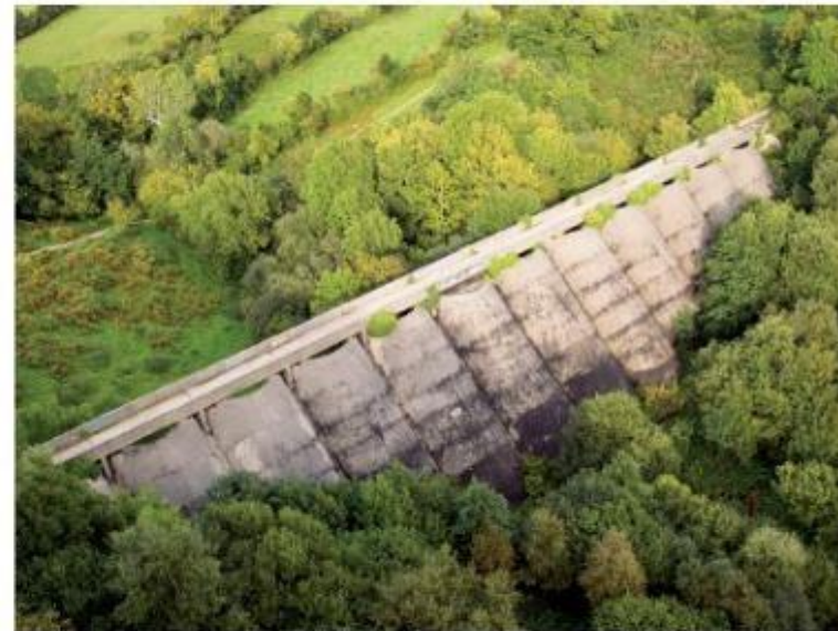
Vue aérienne du barrage du Rouland
