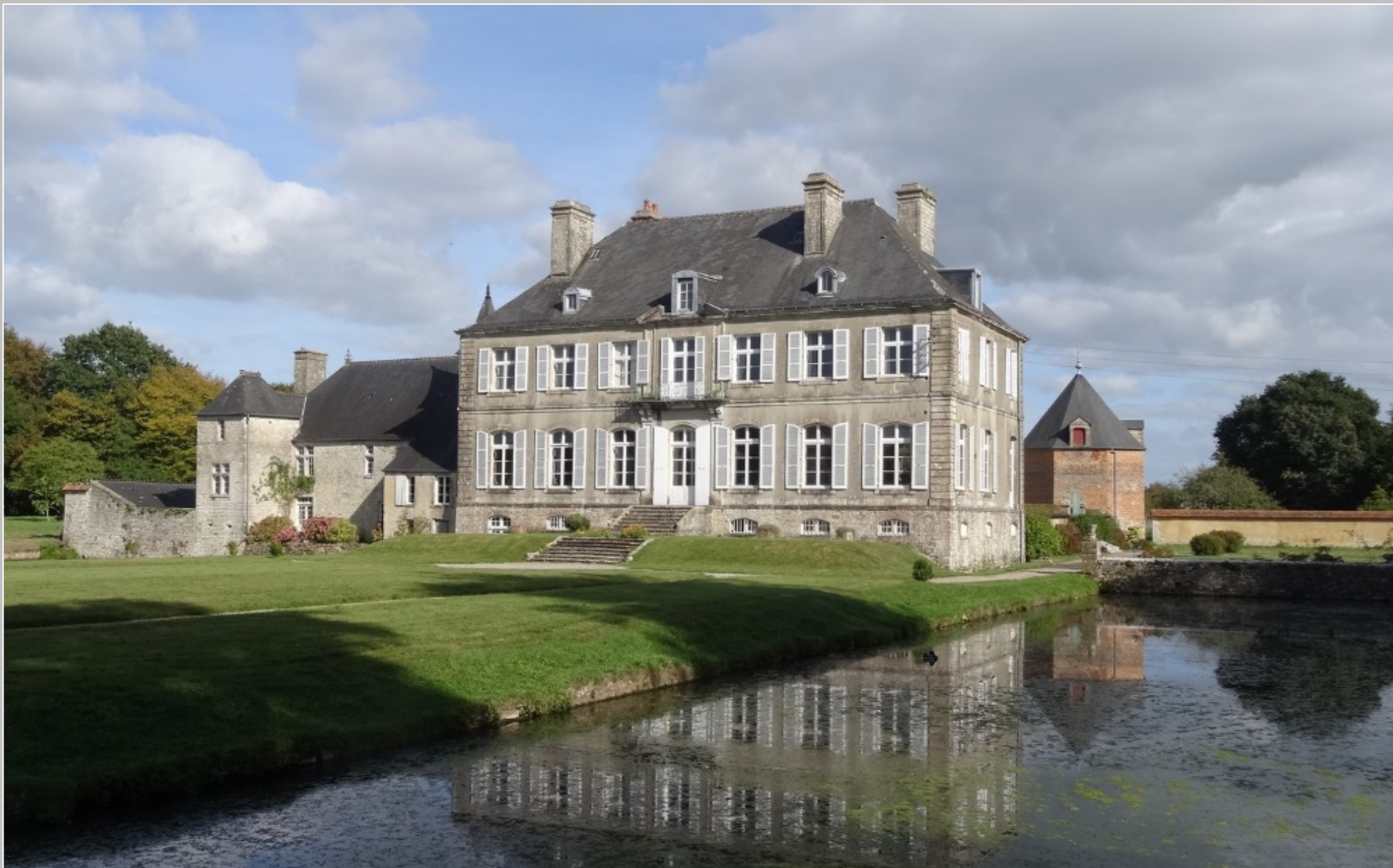
Vue sur l'arrière du château avec le parc et les pièces d'eau.
